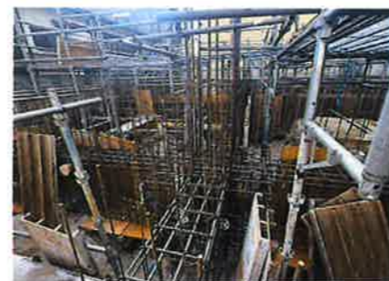
基礎配筋工事
