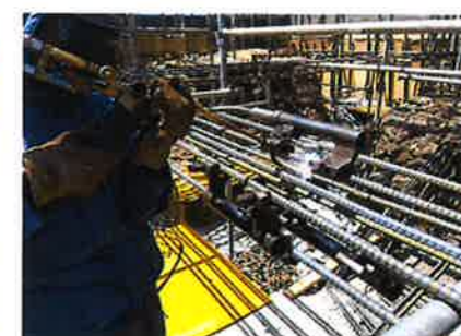
基礎圧接工事
