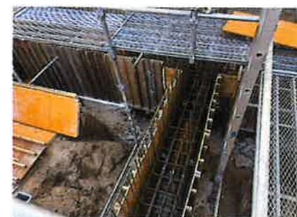
基礎型枠工事
