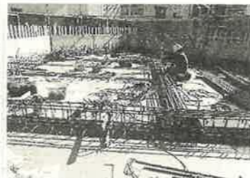
5階床の鉄筋工事です
