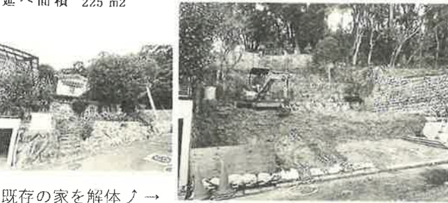
既存の家を解体中
