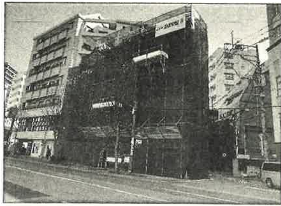
(仮称)薬院ビル 新築工事
