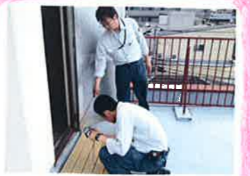
屋上防水状況、サッシ の劣化等をチェックします。
