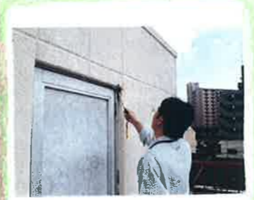
外壁のひび割れ、シーリング の切れ等をチェックします。
